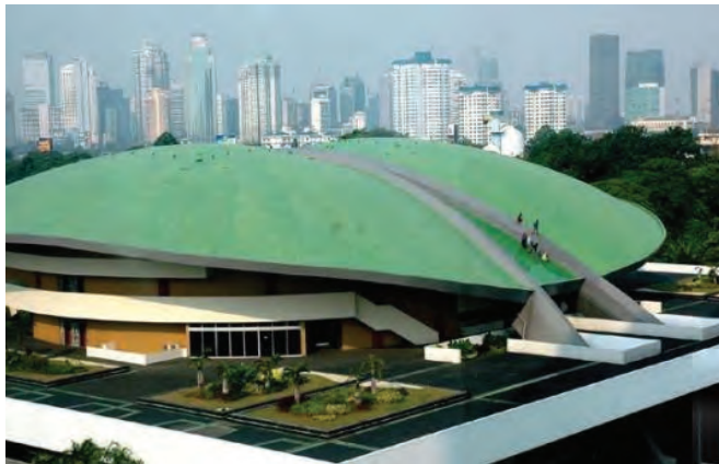
Sumber: http://www.primaironline.comimages_content200994Gedu.bmp Gambar 3.1 Gedung MPR/DPR merupakan gedung tempat bekerja dan berkumpulnya wakil rakyat untuk kesejahteraan rakyat Indonesia.
